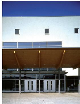
Die Stahlbetonskelettkonstruktion ist fugenlos ausgebildet. Wände und Stützen sind Fertigteile, die Flachdecken sind in Ortbeton hergestellt. Das Gebäude ist ohne Untergeschoss auf Ortbetonrammpfählen gegründet.
